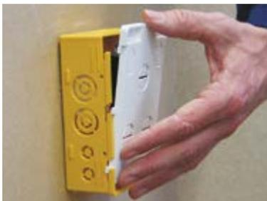
3) Imagine laterală (în secțiune) asupra dozei introduse prin dosul plăcii de rigips.
