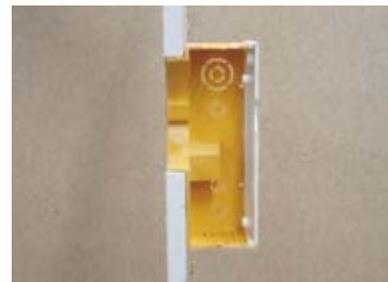
4) Fixarea dozei prin șuruburile autoforante. Detaliu spațiului separat pentru șurub.
